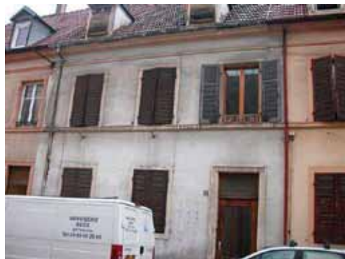
Mulhouse, bâtiment avant réhabilitation.
